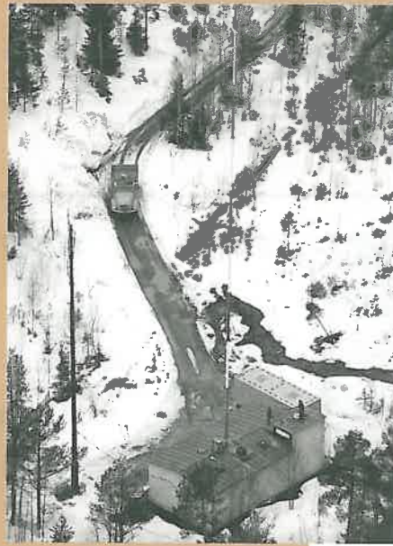
Bild 3. Bilden ger en föreställning om hur båtsmansstolen hissades med hjälp av lastbil. Draglinan syns lite grann vid fronten på lastbilen.
