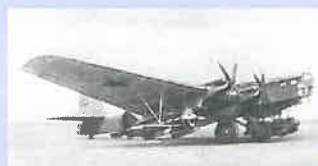
Bild 7. Zveno 6SPB. Lägg märke till de starkare M-34 motorerna och det ”uppsnyggade” landningsstället i denna sena version av TB-3.
